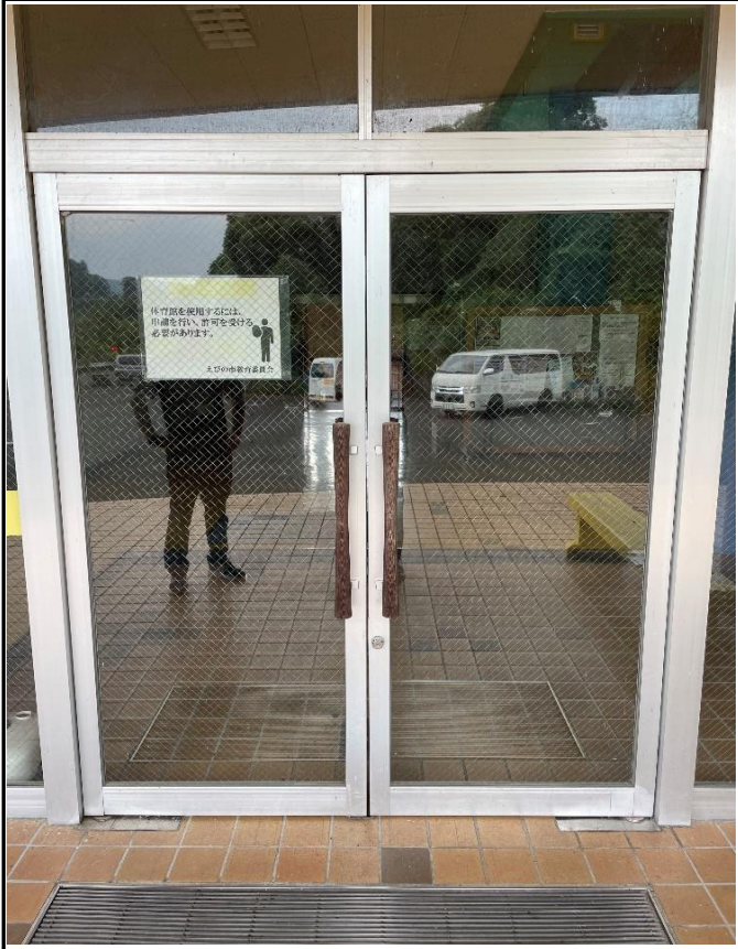
No.4 上江地区体育館 【正面玄関】
