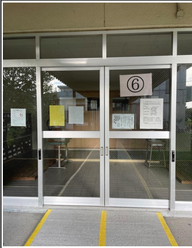
No.15 加久藤小学校体育館 【正面玄関】
