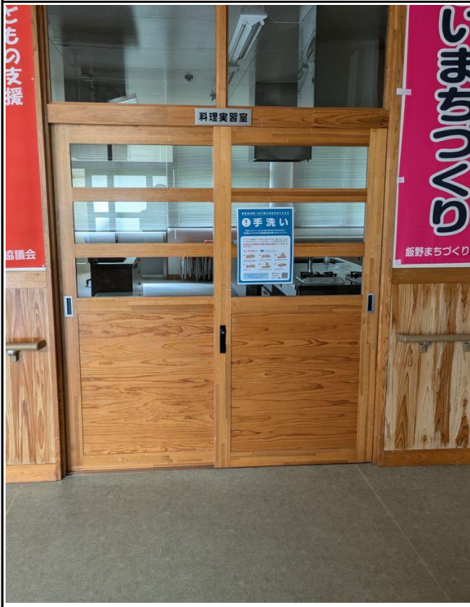
No.5 飯野地区コミュニティセンター 【調理室】
