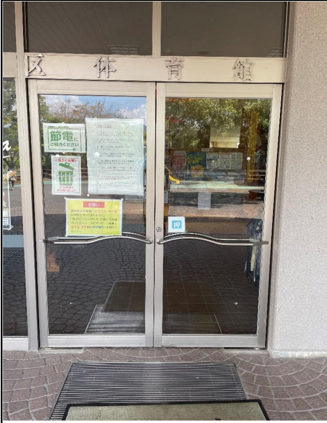
No.8 真幸地区体育館 【正面玄関】
