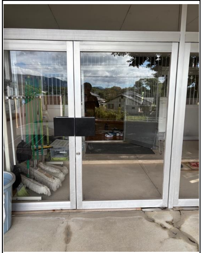
No.18 飯野中学校体育館 【正面玄関】
