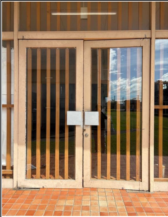
No.13 飯野小学校体育館 【正面玄関】
