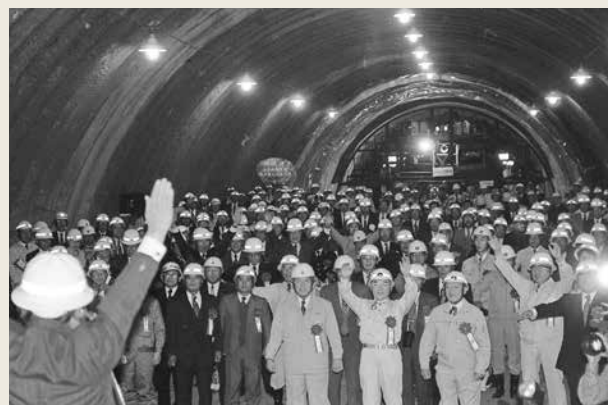
九州縦貫自動車道加久藤トンネル貫通
