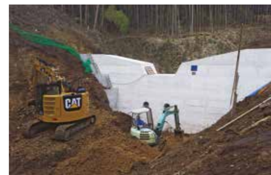
▲重機での土砂掘削(砂防工事)
