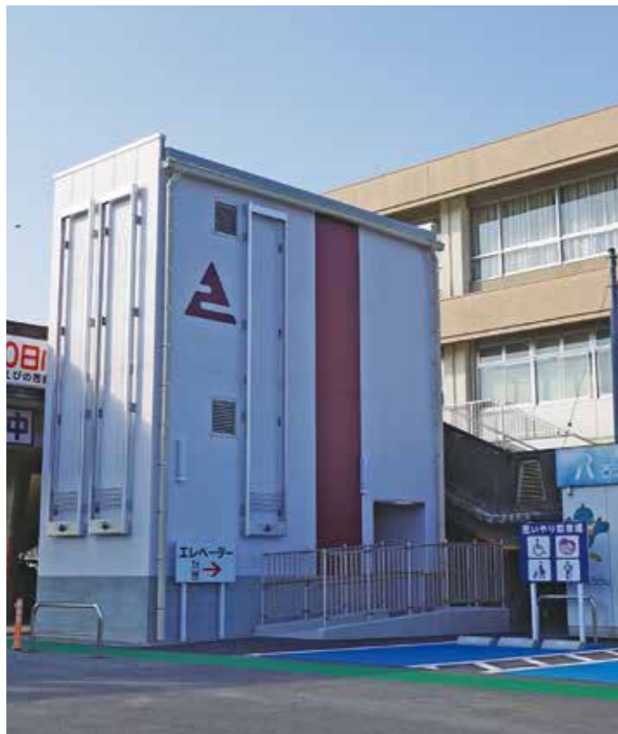
ATM 南側に設置された屋外エレベーター
