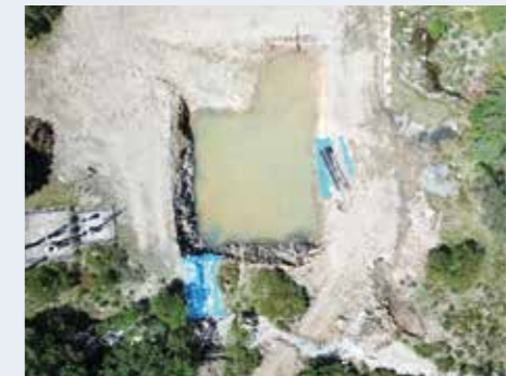
えびの高原韓国荘跡地沈殿池完成 (写真提供：国土交通省川内川河川事務所)
