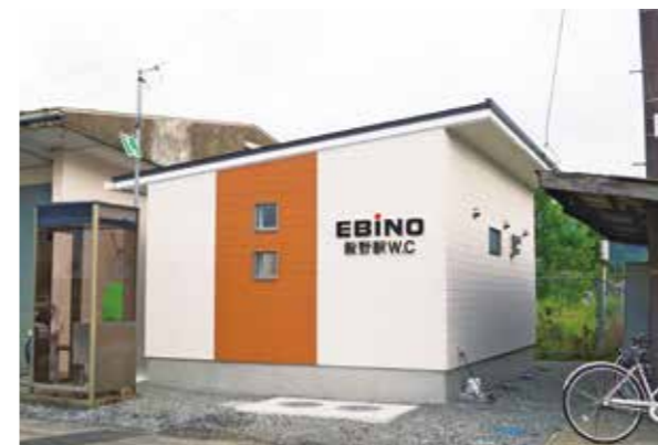
水洗トイレを新築(えびの飯野駅をといちらかさん会)
