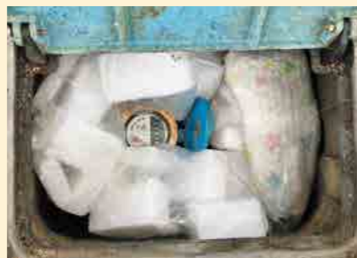
水道メーターボックスの中に保温材を入れて保温する
