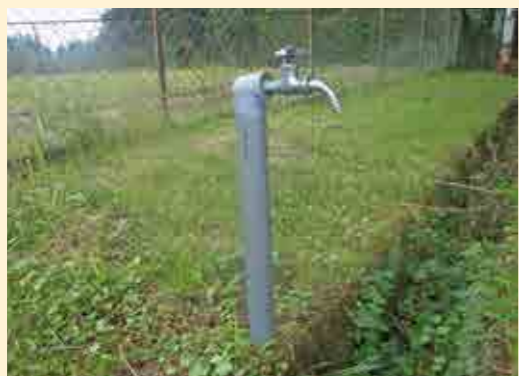
屋外にある水道管や蛇口に保温材を巻くなどして保温する
