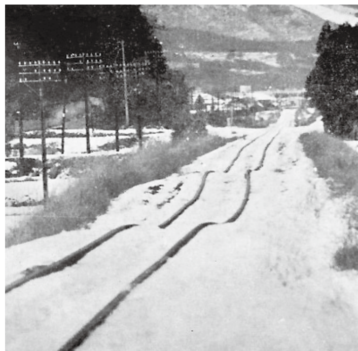
激しく波打っているレール・路盤 (吉布線京町駅から鶴丸駅間)
