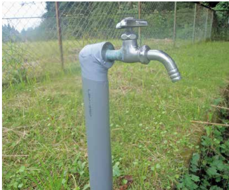
屋外にある水道管や蛇口に保温材を巻くなどして保温する
