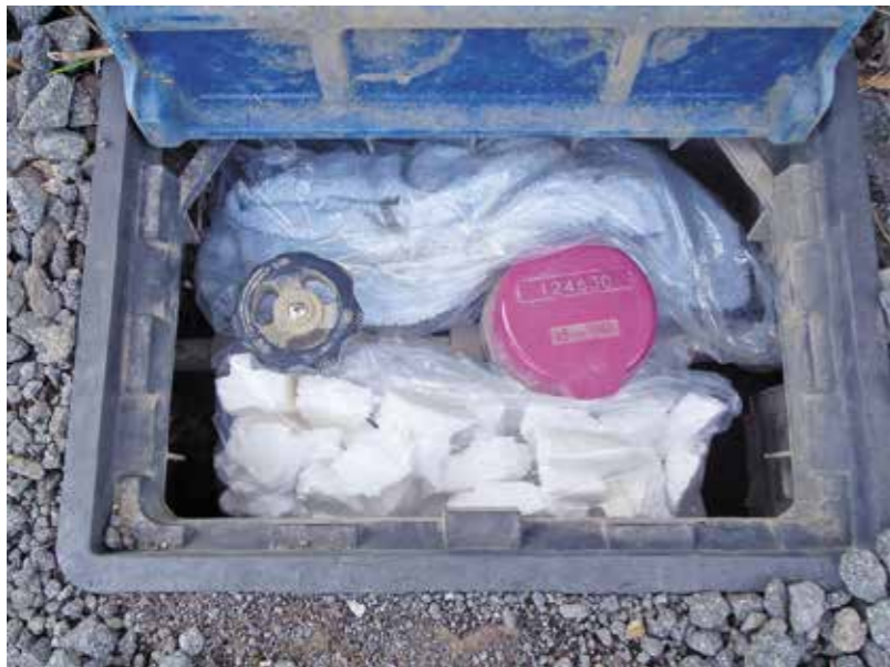
水道メーターボックスの中に保温材を入れて保温する
