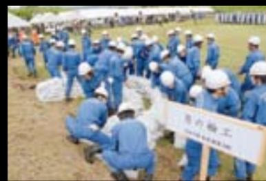
水防団による水防工法の実施訓練。土のう作りをはじめ、状況に応じた工法を実施した。上の写真は堤防の越水、漏水亀裂による堤防決壊を防ぐために行う「月の輪工」。
