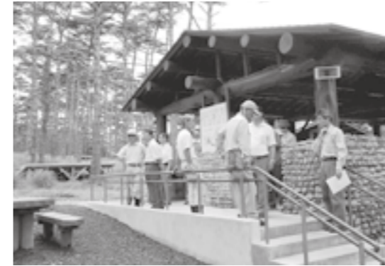
新築されたCサイトの炊事棟。
