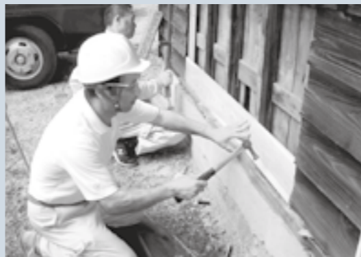
真幸駅舎の壁板を張り替える建築技能連合会のメンバー。
