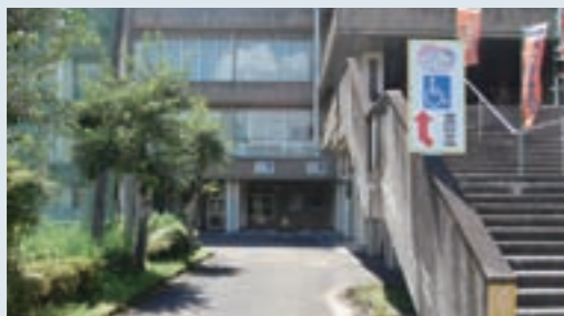
④正面が守衛室となっています。その手前が駐車場となっています。
