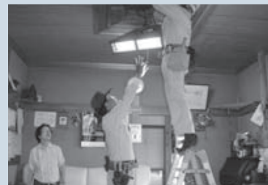
電気の点検・交換を行う組員
