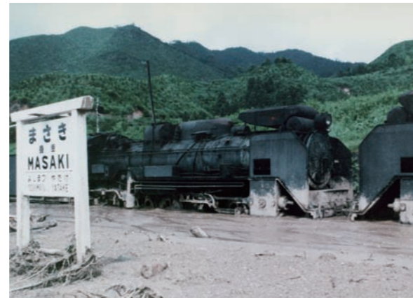
昭和 47 年 7 月 6 日、まさき山津波の被害を受けた真幸駅
