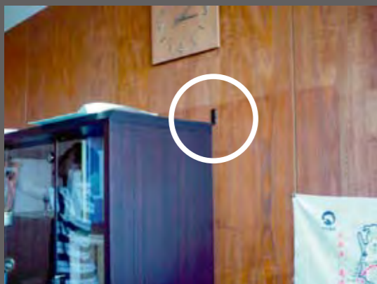
L型金具などで壁に固定する工夫を（消防科学総合センター）
