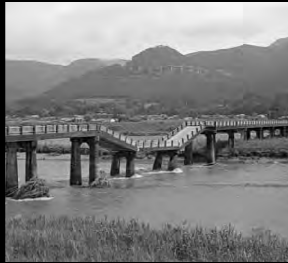
平成 5 年 8 月 6 日の集中豪雨で倒壊した湯田橋
