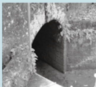
手彫りされた取水トンネル
