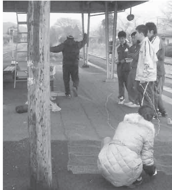
えびの飯野駅で行ったハトよけネット取り付け作業
