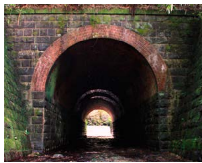
瀬久谷川暗渠
