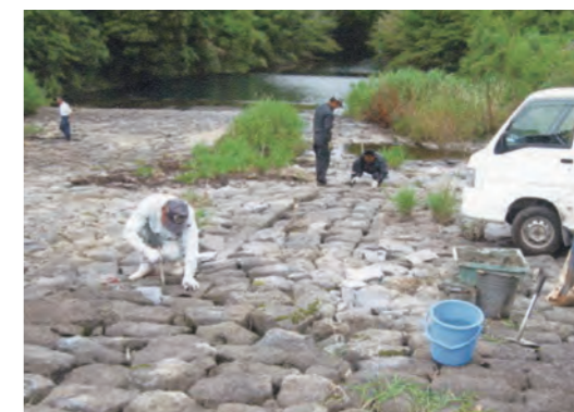
敷石の石詰め作業（巻きかやし二俣公園保存有志会）
