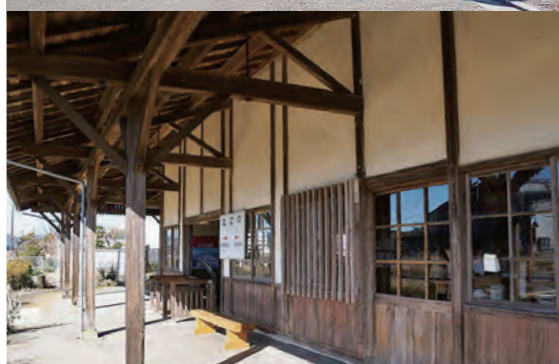
建物の構造は、瓦ぶきの切妻屋根木造平屋造り
