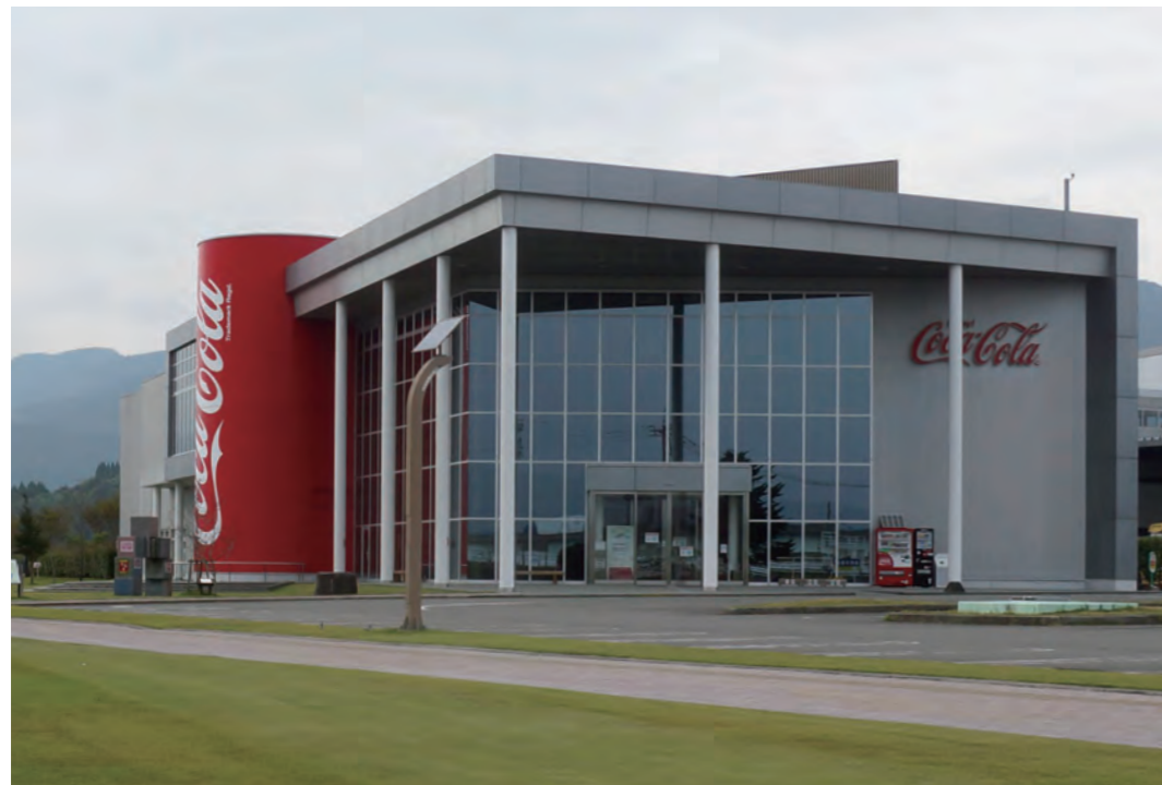
コカ・コーラウエスト株式会社えびの工場
