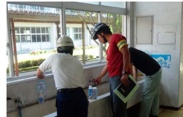
管工事協同組合青年部が点検・修繕
