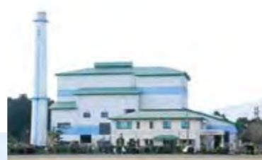
▲えびの市美化センター 平成9年に完成したごみ焼却施設。焼却の際に発生する余熱を利用した浴場を併設しており、市民らに広く開放しています。
