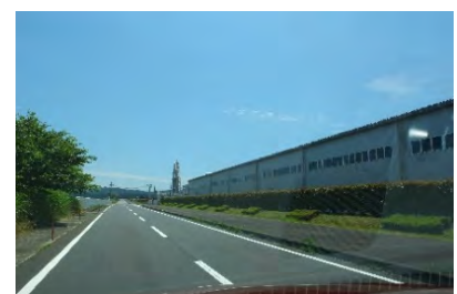
IC 付近の工業施設
