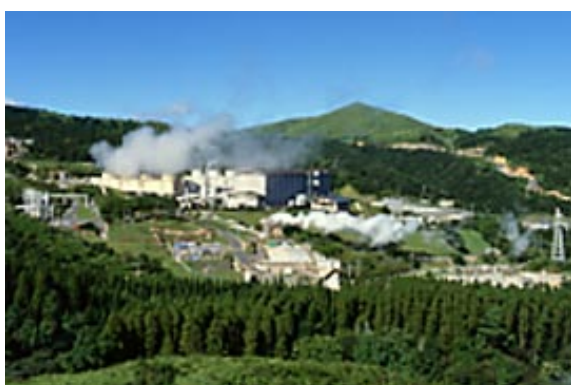
写真：大分県九重町の八丁原地熱発電所
