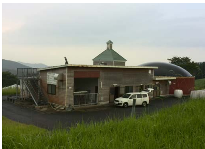
写真：県内に設置されているバイオガス発電設備（都城市、高千穂牧場）
