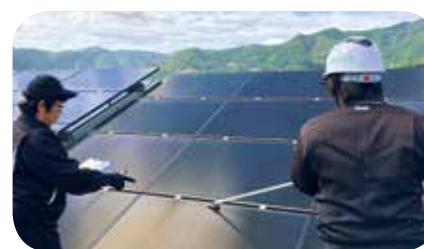
専用の機器で故障を発見します
