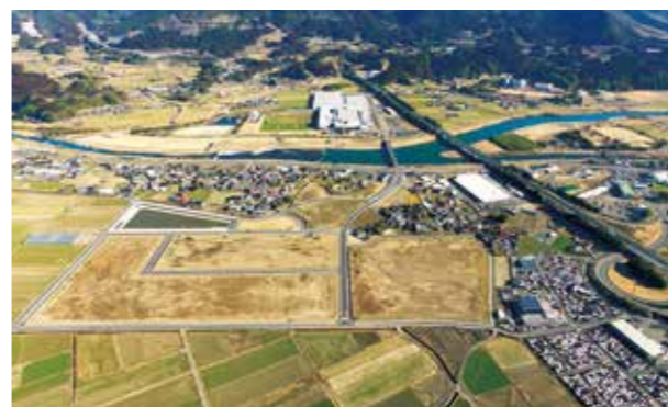
完成した産業団地
