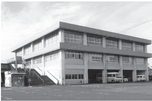
建替えるとしたら約50億円必要な市庁舎
