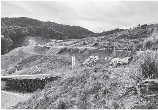
トンネル工事中の国道447号線
