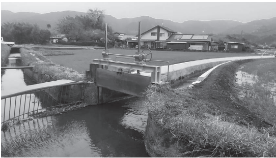
水害対策が進む西郷霊園付近
