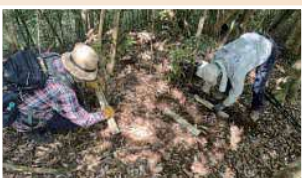
設置作業の様子
