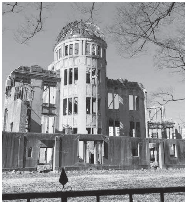
被爆当時の痕跡を残す原爆ドーム
