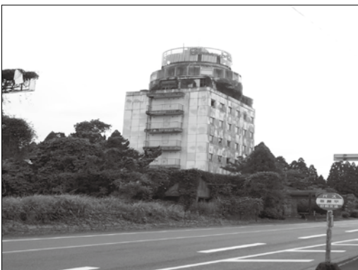
撤去が求められるホテル跡廃屋
