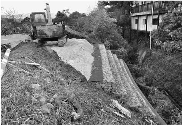
災害復旧工事
