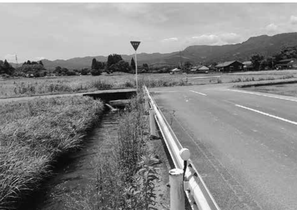
改修が必要な西郷耕地7号線と水路
