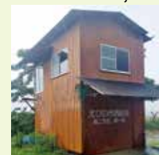
建て替え予定の消防詰所
