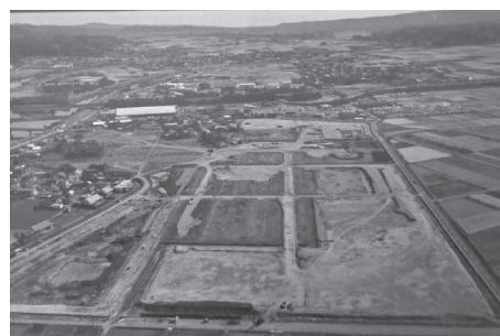
造成工事が進む産業団地
