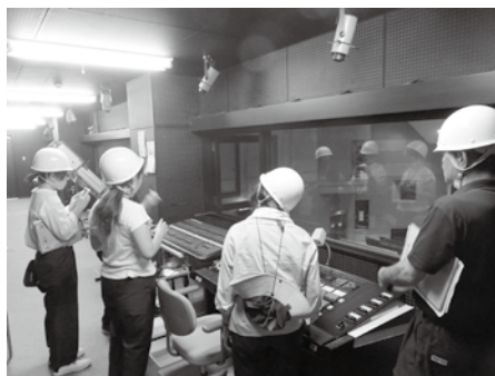
改修された箇所の現場視察 (えびの市文化センター 2F 照明室)
