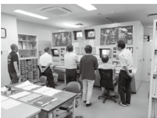
改修された箇所の現場視察 (えびの市美化センター)
