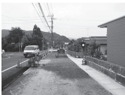
県道改良工事の施工状況
