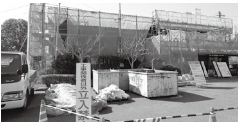
耐震・改修工事が進むえびの駅駅舎
