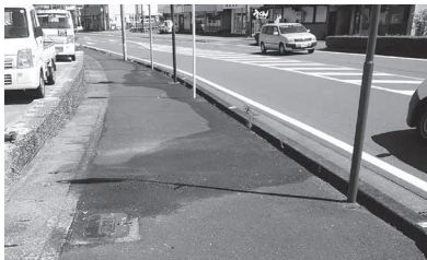
漏水が確認された飯野地区の消火栓
