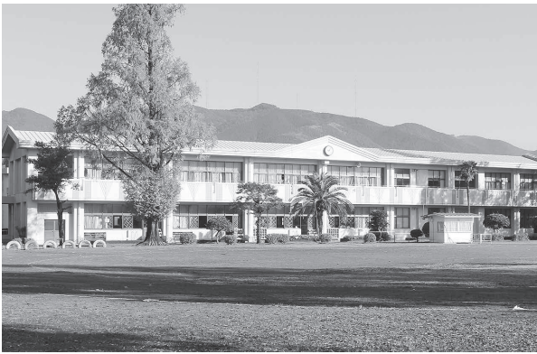
市内全学校施設への早期の冷暖房設置が必要
