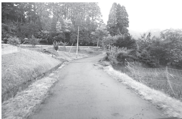
市道後川内線から急勾配付近
