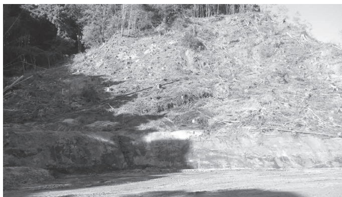
国道沿いの伐採現場
