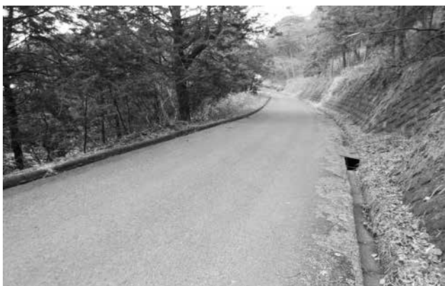
畜産振興のためにも道路拡張が望まれる市道大迫霧島線
