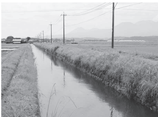
排水調査が重要視される堂本用水路
