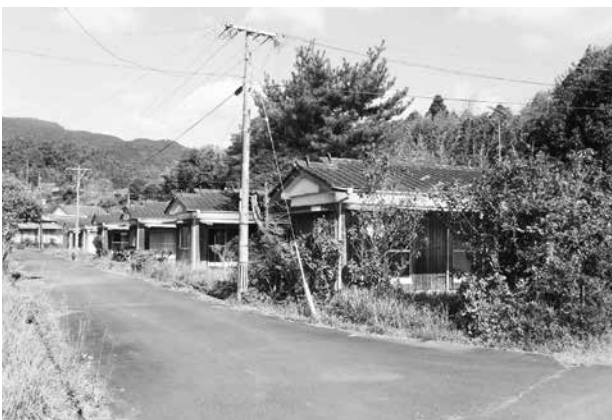
跡地利用が検討されている旧川原教職員住宅敷地
