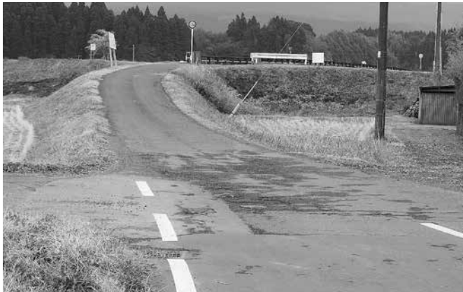
改良が望まれる前田橋及び周辺
