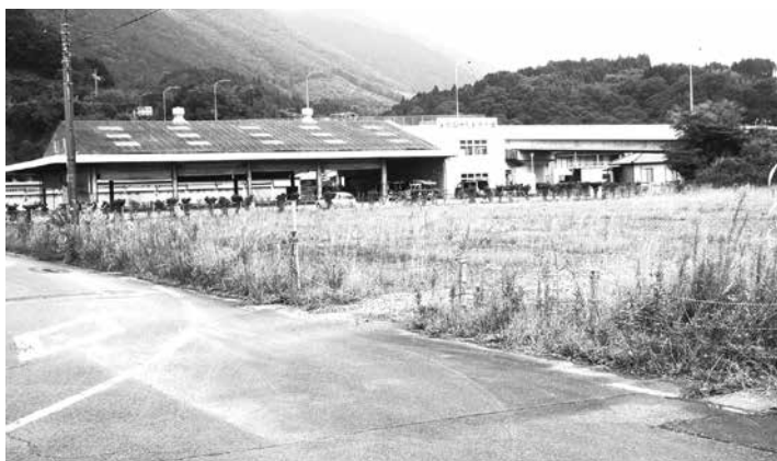
進出が決定している物流会社建設予定地
