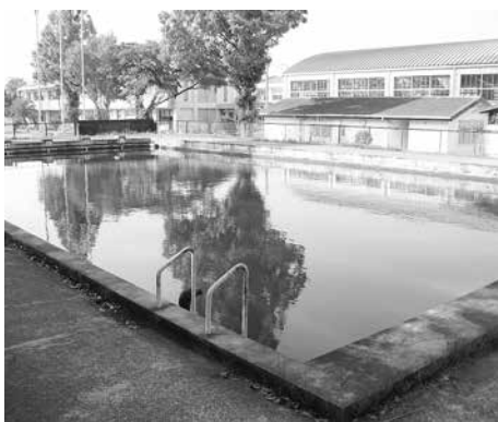
改修が決まっている加久藤小学校のプール
