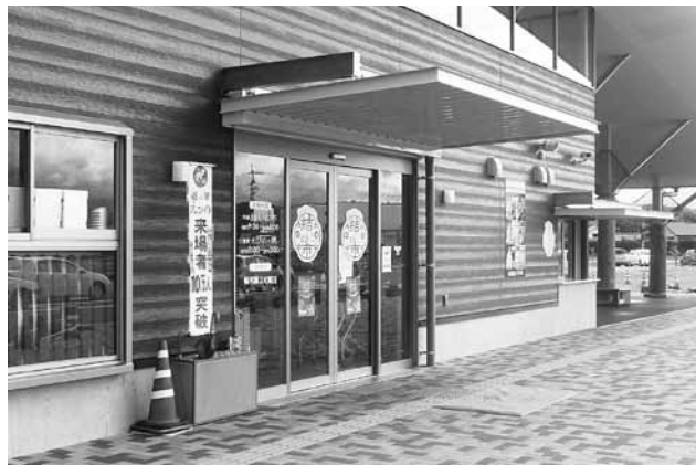
施設改善を指摘している道の駅正面玄関
