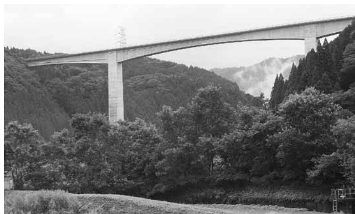
上水道大河平配水系整備が実施されるくるそん大橋
