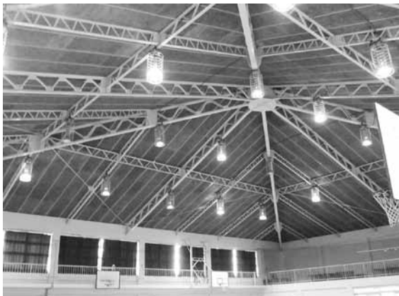
天井修繕を行う飯野中体育館
