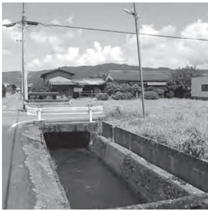
排水調査が始まった南原田地区
