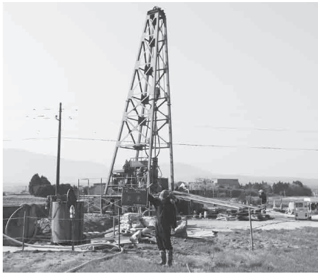
第2水源のボーリング調査
