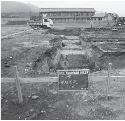
建設工事が始まった「交流物産館」
