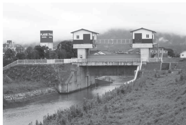
新設された西境川水門
