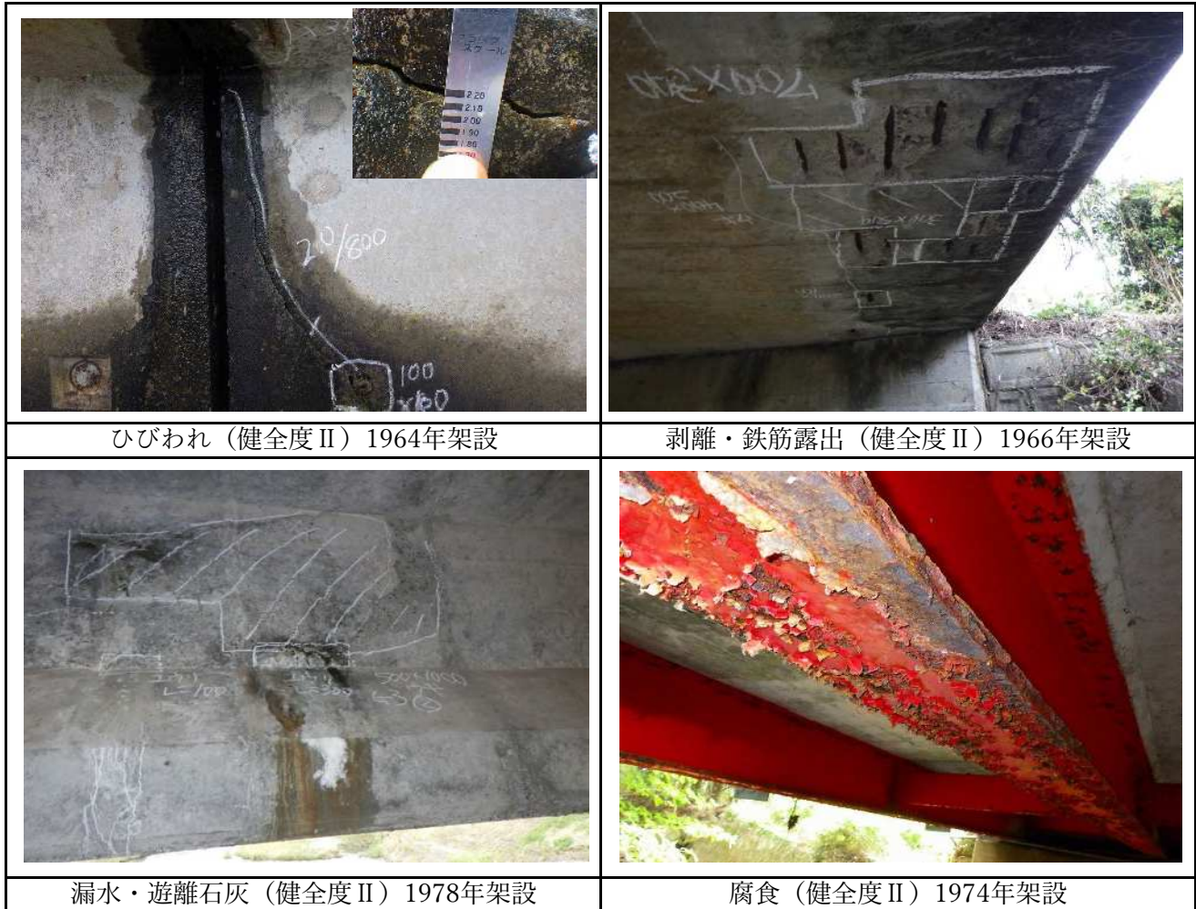
図 6 損傷状況
