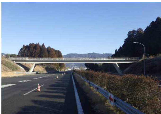
図 10 道路を跨ぐ橋梁の例（えびの市管理 灰塚橋）
